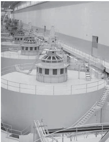
Aplicación de bombeo
