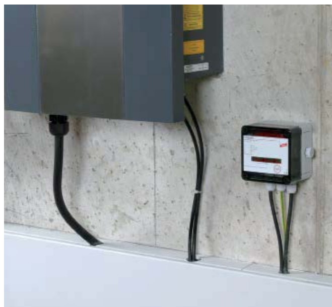
Para la protección de instalaciones de consumidores de baja tensión contra sobretensiones. Para su utilización según IEC 60364-7-712:2002-05 "Instalación en sistemas de alimentación fotovoltaicos".
