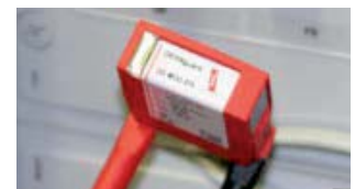
Conexión directa a un módulo de protección DEHNguard.
