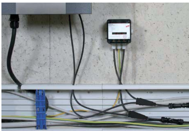
Cables de conexión precableados para la conexión fácil de los cables de string con DEHNCube y el inversor.
