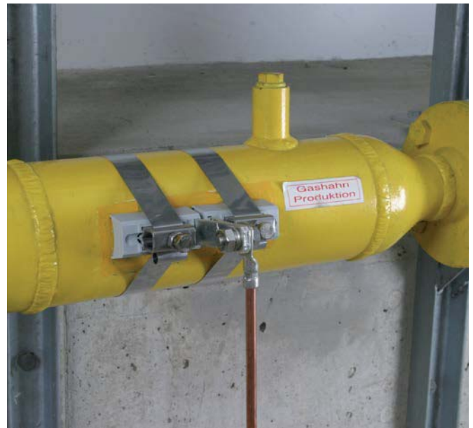
Abrazadera de banda para compensación de potencial de protección contra rayos de tuberías en zonas Ex
