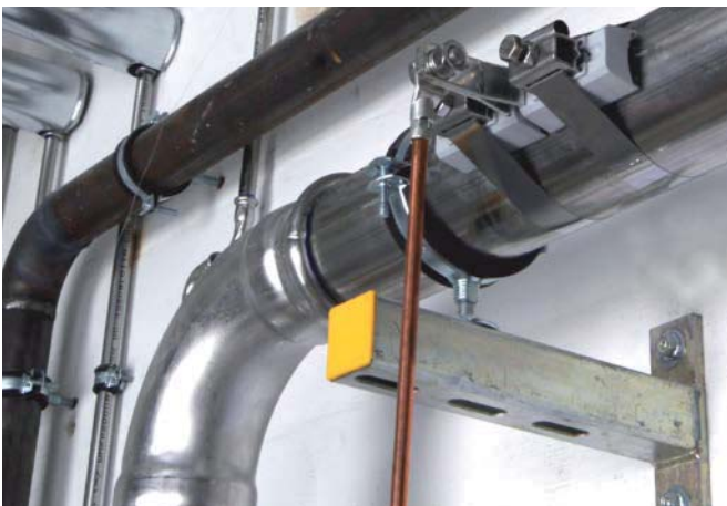
Instalada sobre un tubo de acero inoxidable.
