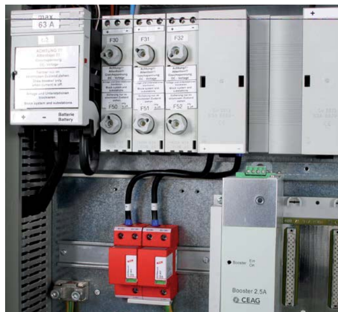
Para protección de instalaciones de consumo en corriente continua contra sobretensiones e incluso impactos directos de rayo. Para su utilización de acuerdo con el concepto de zonas de protección contra rayo, en las intersecciones 0_A - 1 .
