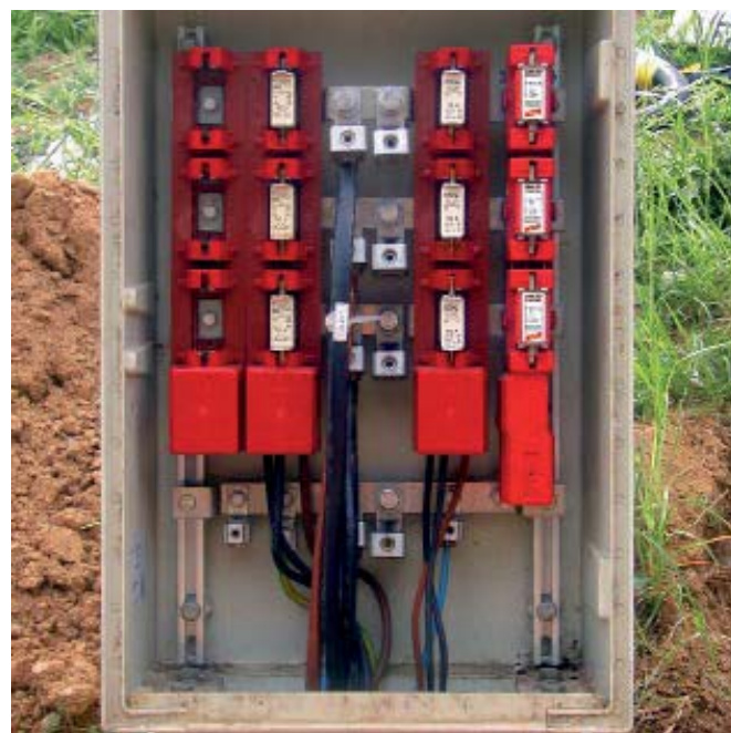
Para protección de instalaciones de consumidores de baja tensión contra sobretensiones. Para su utilización en los puntos de intersección 0_B - 1 y superiores dentro del concepto de zonas de protección contra rayos. Patente DE.
