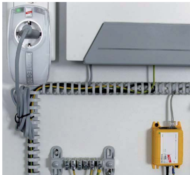
Descargadores de sobretensiones para equipos finales de telecomunicaciones e instalaciones telefónicas con conectores enchufables RJ.
