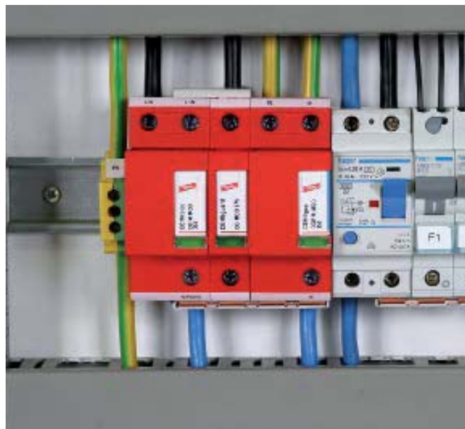
Para protección de instalaciones de consumidores de baja tensión contra sobretensiones, incluso en caso de descargas directas de rayo. Para su utilización en el concepto de zonas de protección contra rayos en las intersecciones 0_A - 1 , en la variante de circuito 3+1.
