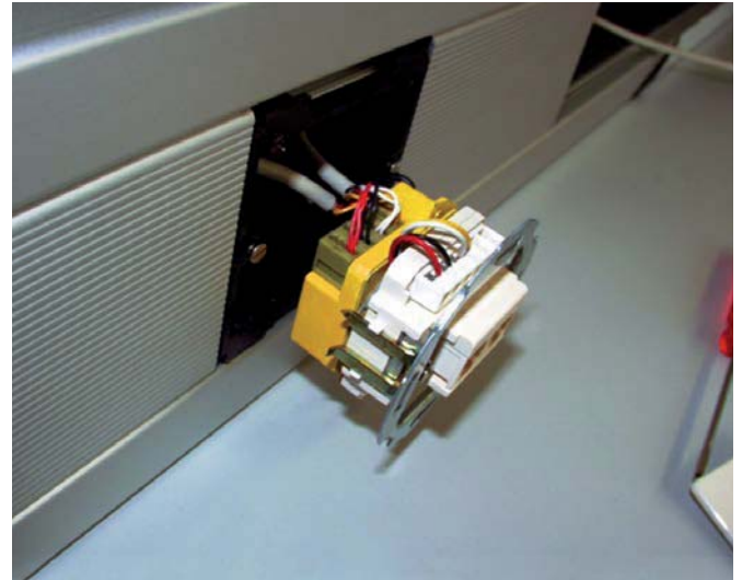
Descargador de sobretensiones para protección de aparatos de telecomunicaciones. Para montaje en cajas de enchufes bajo pared o en pequeños distribuidores.
